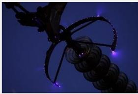
يؤدي تأيين جزيئات الهواء حول خطوط النقل (عند رفع جهدها الكهربائي إلى مقادير أكبر من النهاية القصوى للجهد المسموح) إلى جعل الهواء موصلاً للكهرباء فينتقل خلاله تيار كهربائي على شكل شرار من الاسلاك إلى الأجسام المحيطة، مثل الأبراج التي تحمل الاسلاك، وهذا بدوره يشكل خطورة ينتج عنها حدوث الحرائق، إضافة إلى فقدان الطاقة الكهربائية أيضاً.
